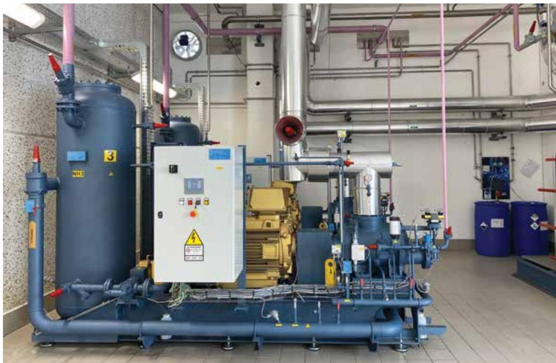
Le unità di compressione sono dotate di inverter ad alta efficienza Danfoss
